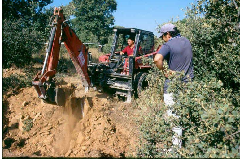
Foto 3.- Detalle de los trabajos de excavación con máquina supervisados por el arqueólogo.
